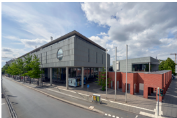
図1 ドイツ国立図書館フランクフルト館、入口外観
